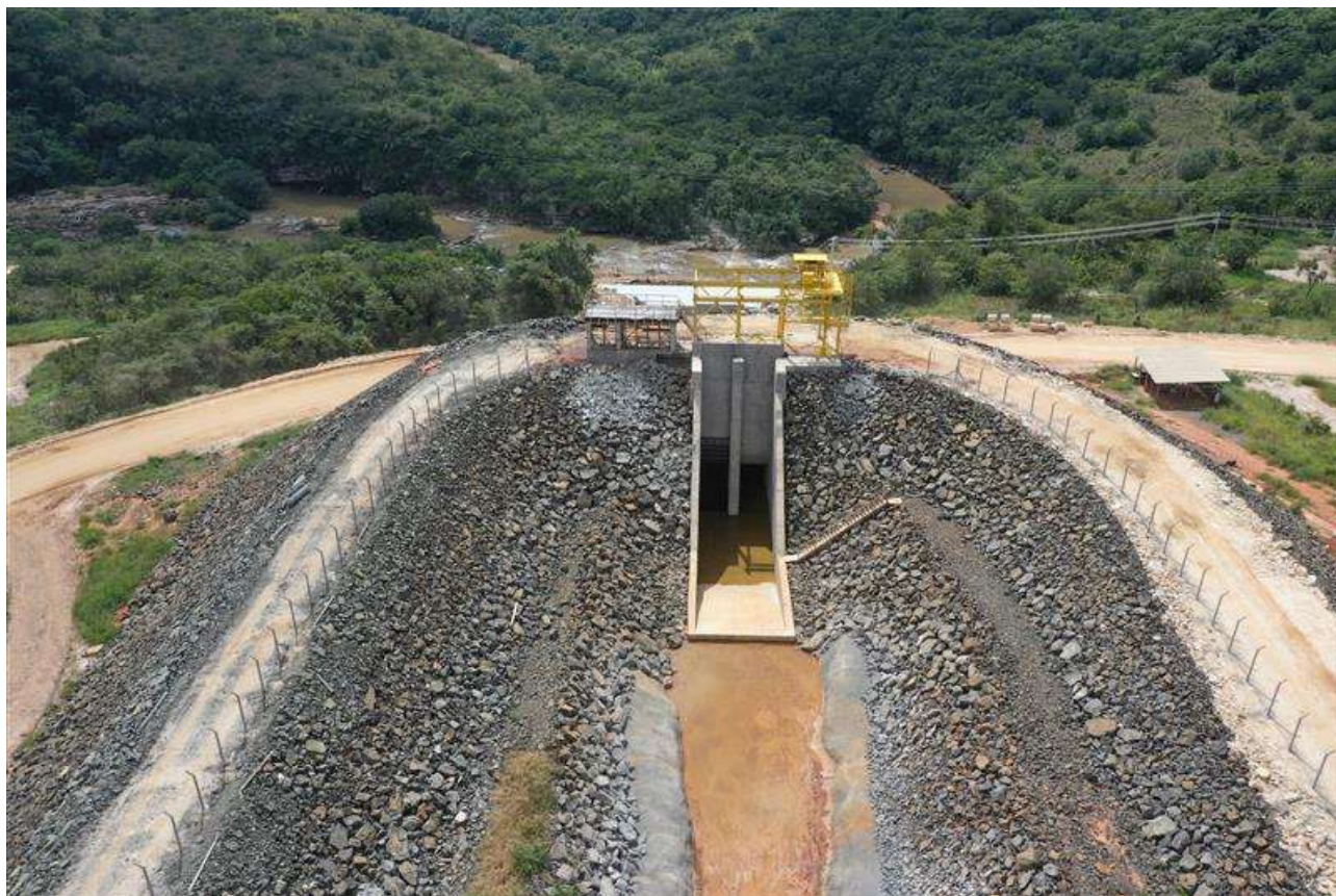
Figura 14 – Detalhe do cercamento e da tomada d'água
