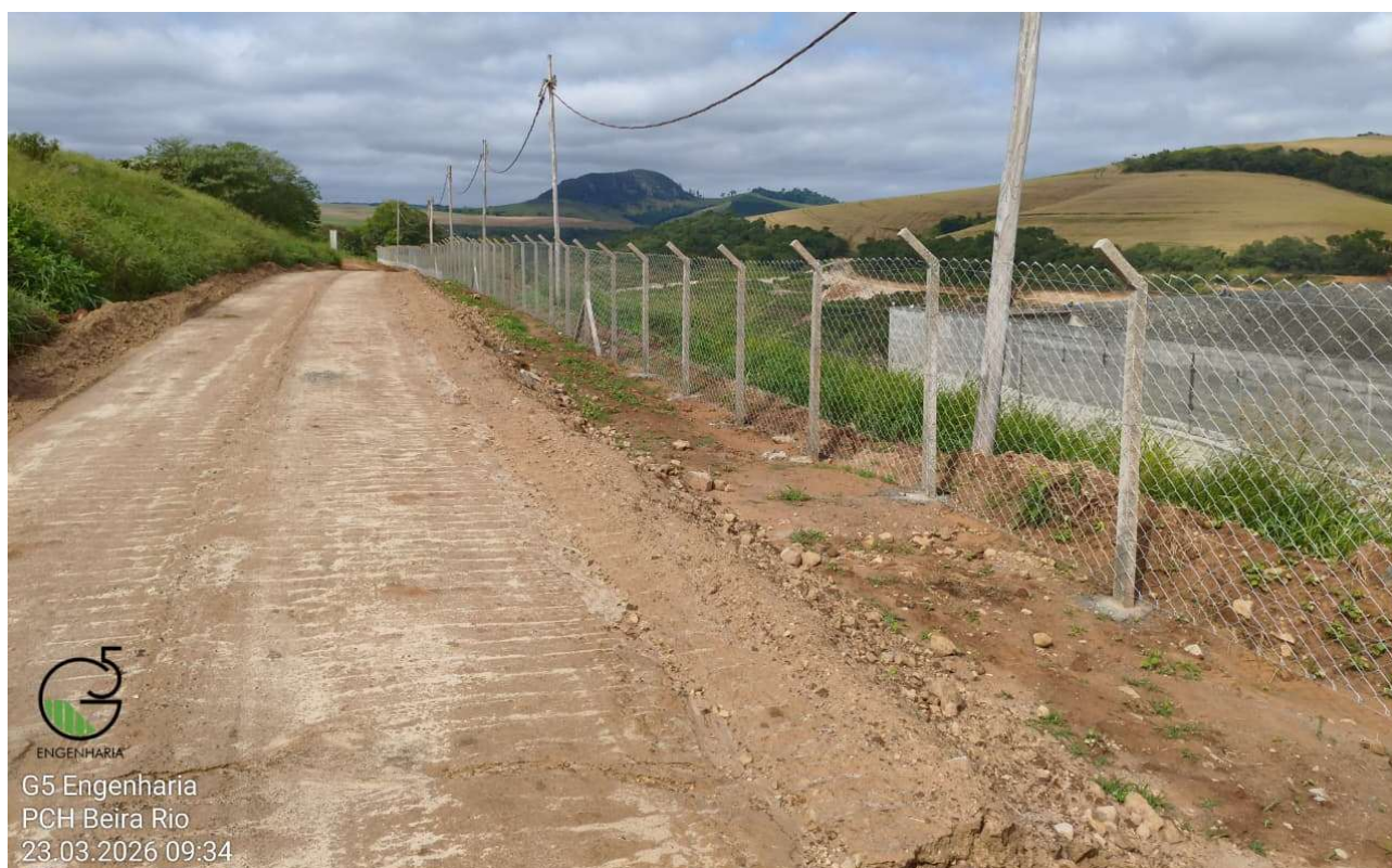
Figura 16 – Cercamento executado ao longo do canal de aproximação
