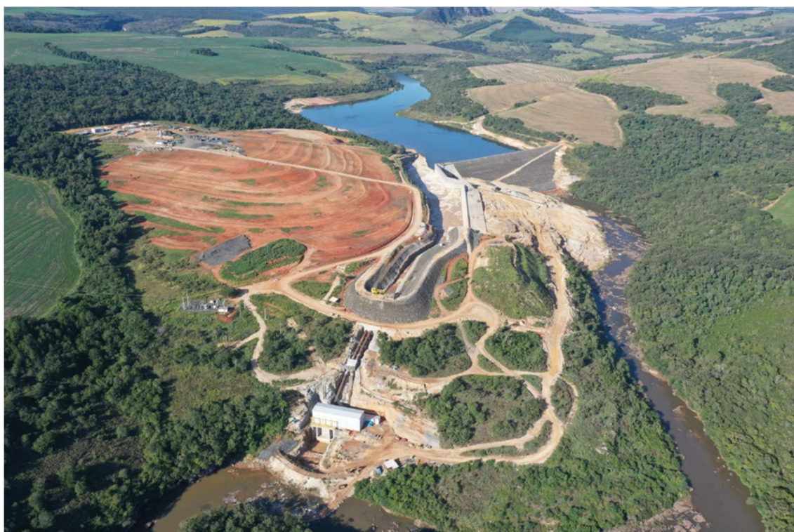
Figura 19 – Visão geral da obra
