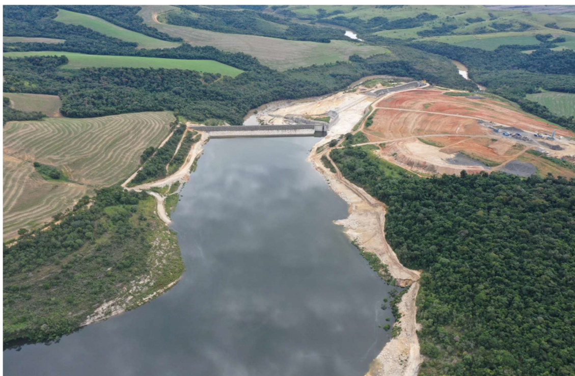
Figura 3 – Área do reservatório da PCH Beira Rio, vista de montante
