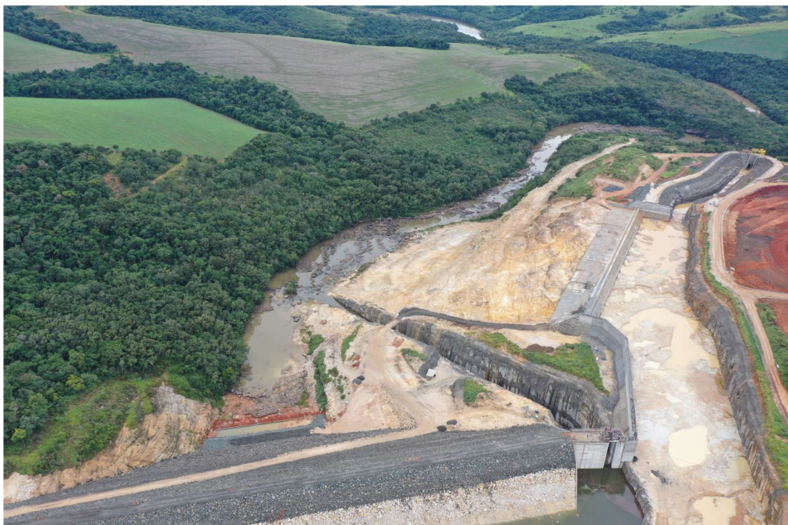
Figura 9 – Detalhe do canal de adução com as ancoragens do log boom e cercamento instalados
