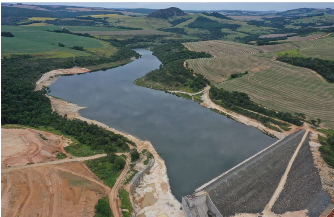
Figura 2 – Área do reservatório da PCH Beira Rio, vista de jusante
