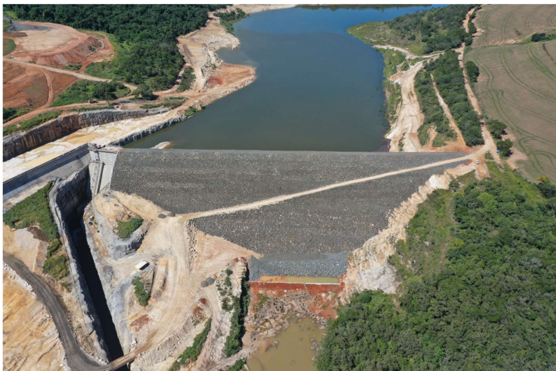
Figura 1 – Barragem e canal de desvio
