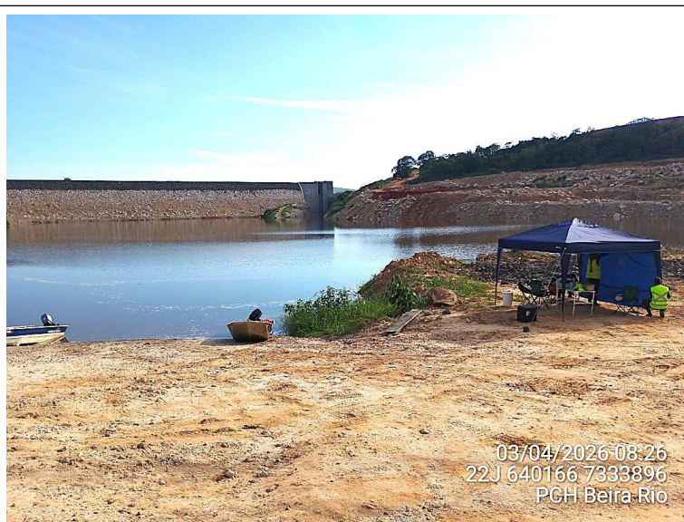
Figura 4 Base de apoio instalada próxima ao eixo de barramento. Noguchi, 03.04.2026
