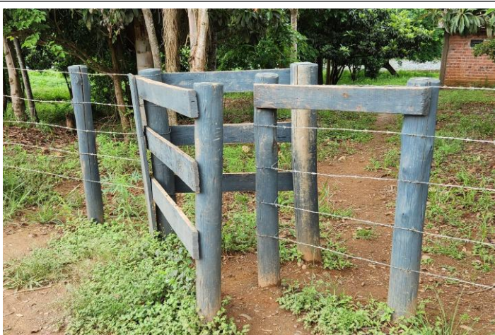
Figura 01: Tipo de passadouro dos pontos de passagem de pescadores à área da APP da PCH Beira Rio Fonte: A.MULLER, em julho de 2024
