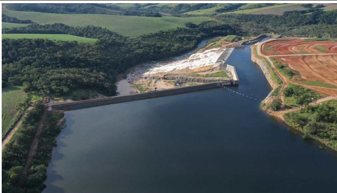
Figura. 06: Vista do reservatório da PCH Beira Rio chegando à cota máxima Drone, em 30/04/2026. G5 Engenharia
