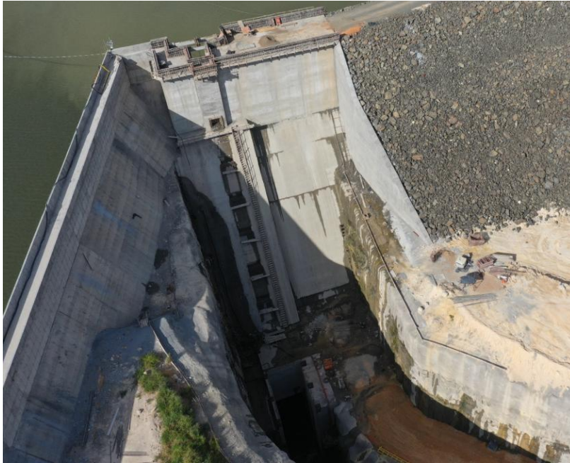
Figura 11: Obras na Casa de Força Auxiliar Em 20/04/2026. G5 Engenharia
