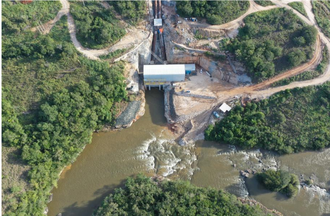
Figura 12: Remoção da Ensecadeira do Canal de Fuga Em 30/04/2026. G5 Engenharia
