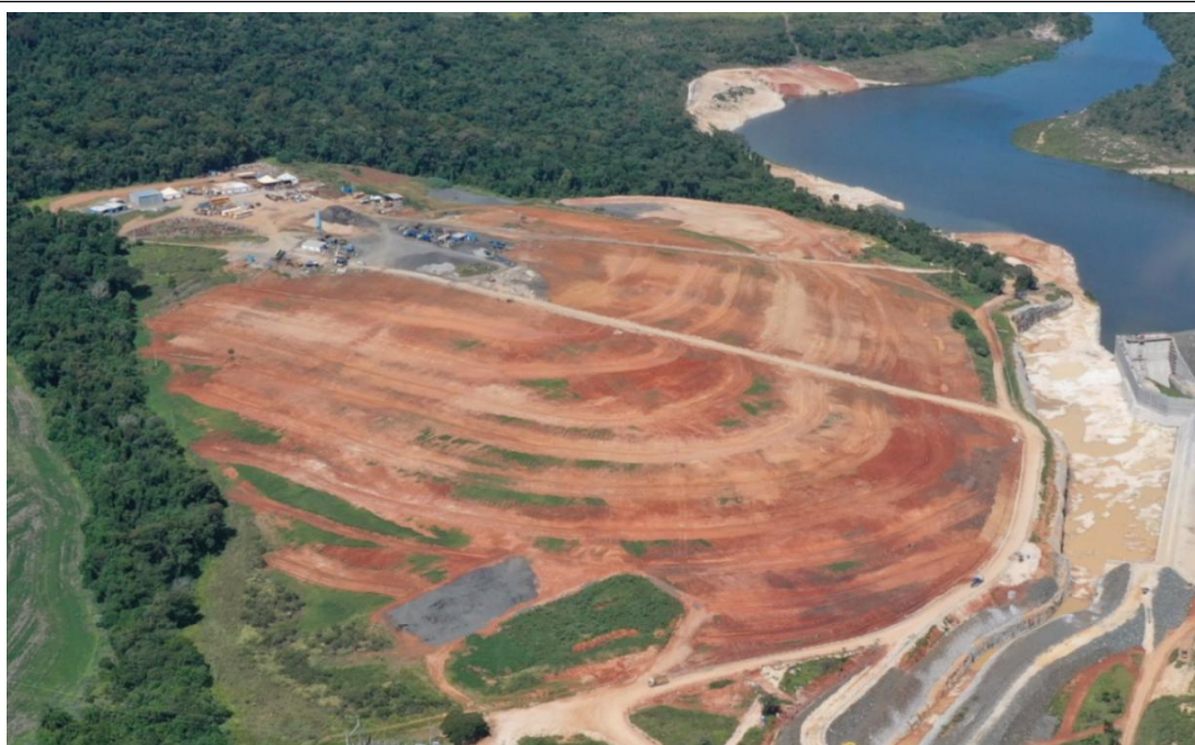
Figura 07: Área do canteiro em processo de desmonte e retirada dos equipamentos Fonte: Drone em 09/04/2026
