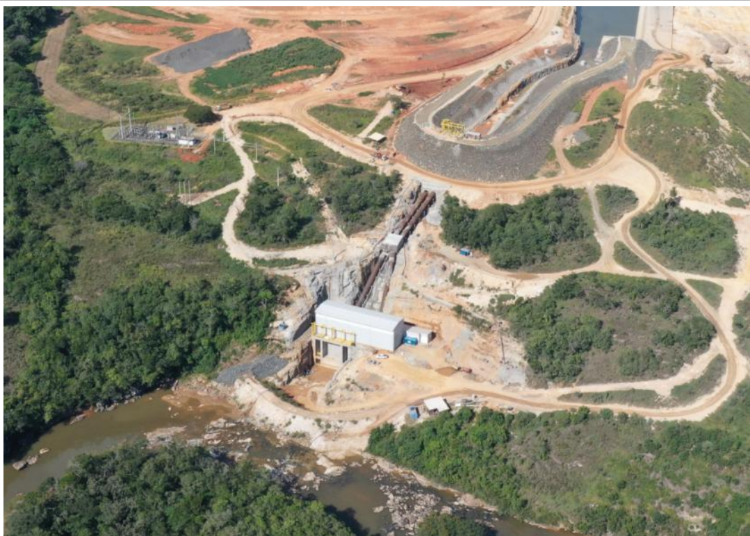
Figura 10: Vista aérea da Casa de Força e canal de restituição, em vias de ser aberto Drone, em 18/04/2026. G5 Engenharia
