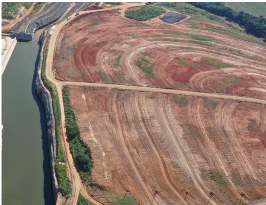
Figura 08: Terreno da jazida de argila já recoberto com camada de solo fértil reservado previamente, onde se fará aplicação de sementeira vegetal. Registro de 18/04/2026, G5 Engenharia
