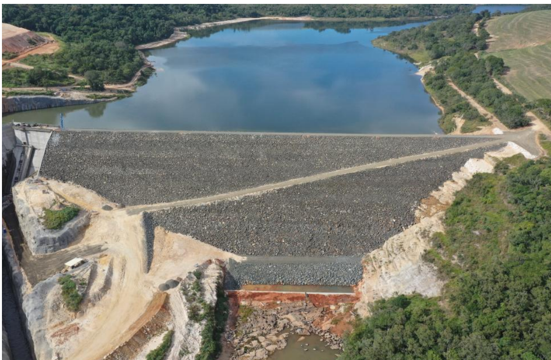
Figura. 05: Barramento da PCH Beira Rio concluído Drone, em 22/04/2026. G5 Engenharia
