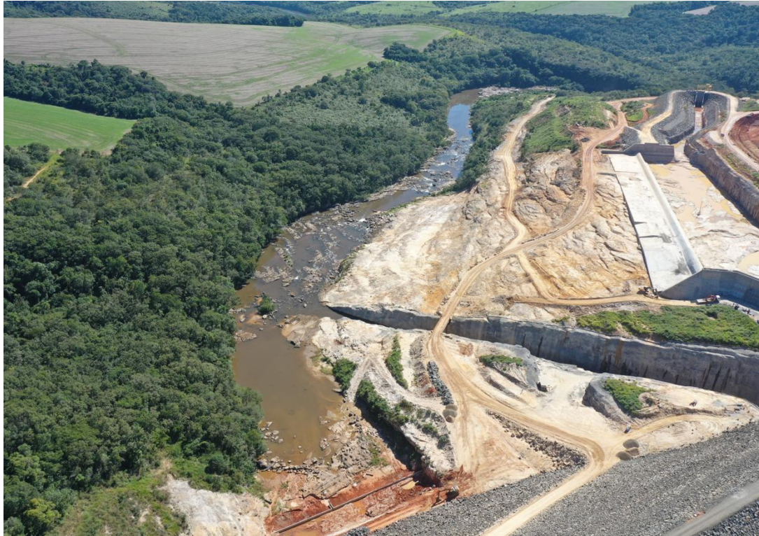
Figura 05: Vista do desague reduzido pelo canal de desvio, ao se iniciar o represamento Drone, em 30/03/2026. G5 Engenharia
