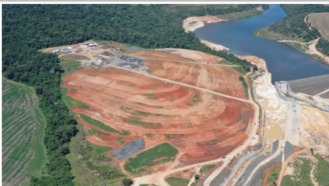
Figura 07: Remodelação da área da jazida de argila, com o terraceamento em curvas de nível para a recuperação vegetal. Registros de 09/03/2026, G5 Engenharia
