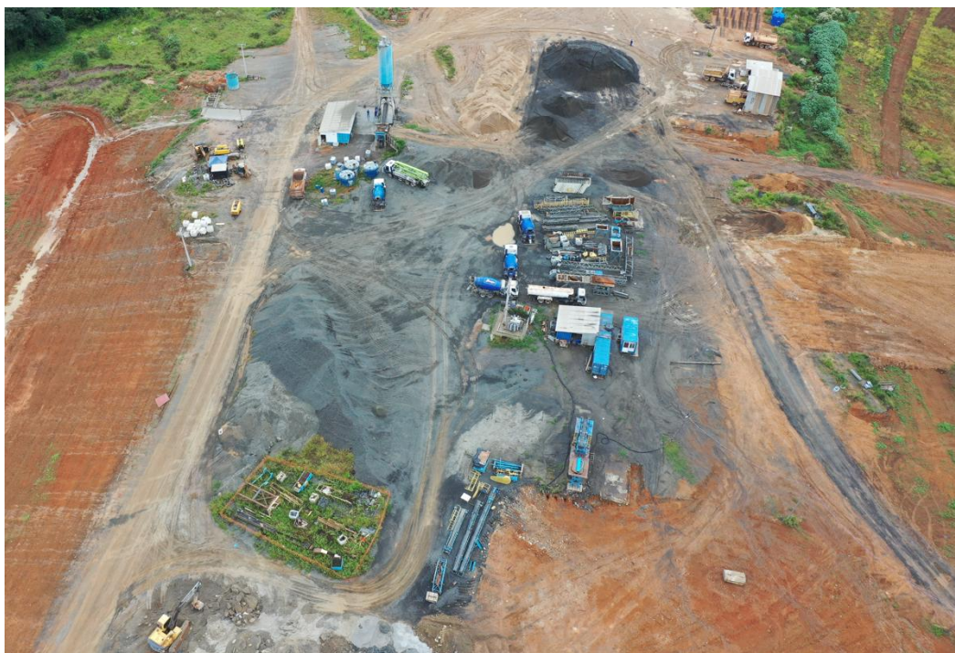
Figura 06: Área do canteiro em processo de desmonte e retirada dos equipamentos Fonte: Drone em 10/04/2026
