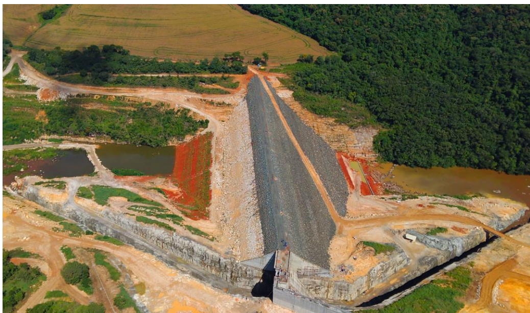
Figura. 02: Registro aéreo da Barragem nos dias em que se concluiu esta obra Drone, em 23/03/2026. G5 Engenharia
