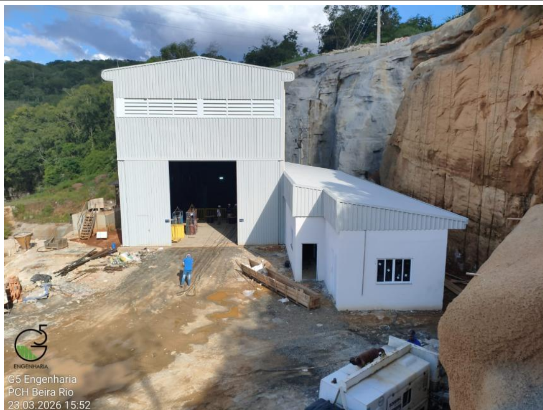
Figura 11: Alvenaria da sala de controle na casa de força Registro em 23/03/2026 – G5 Engenharia
