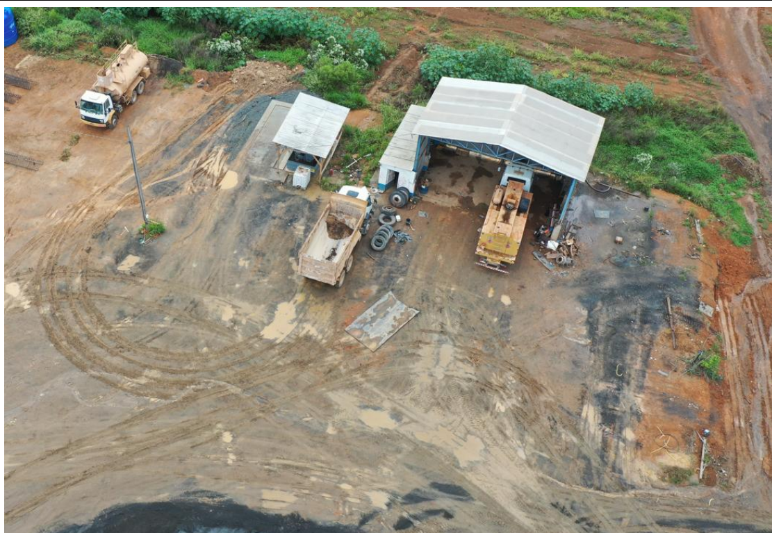
Figura 08: Pátio de máquinas e equipamentos – Registro em 10/04/2026 – G5 Engenharia.
