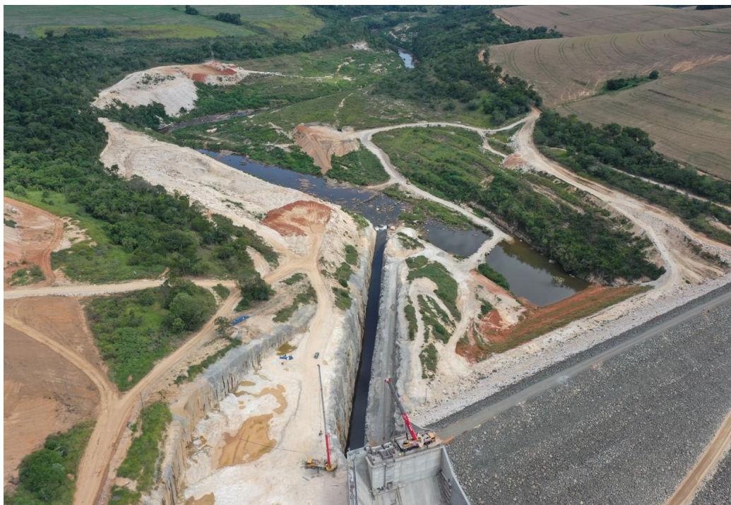
Figura 04: Vista do Momento em que se deu o início da formação do reservatório Drone, em 30/03/2026. G5 Engenharia
