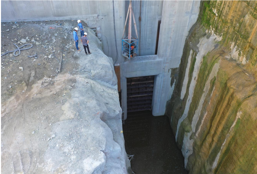
Fig. 01: Operação de vedação da adufa do canal de desvio, dando início à formação do reservatório. Drone em 30/03/2026 fonte: G5 Engenharia
