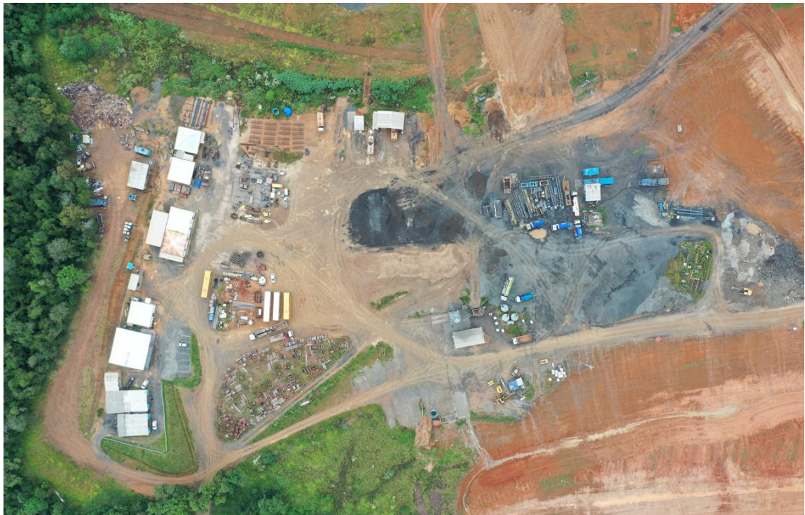
Figura 09: Vista geral da área do Canteiro de Obras Drone, em 10/04/2026, G5 Engenharia.
