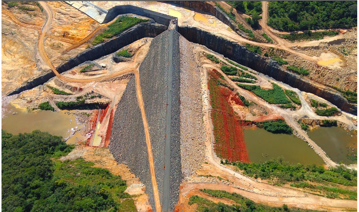
Figura. 03: Vista do Barramento da PCH Beira Rio, concluída Drone, em 23/03/2026. G5 Engenharia
