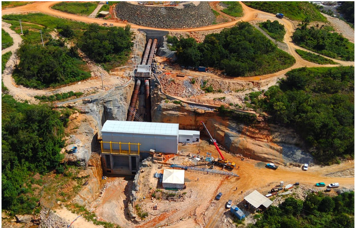
Figura 12: Casa de Força Drone, em 13/03/2026. G5 Engenharia
