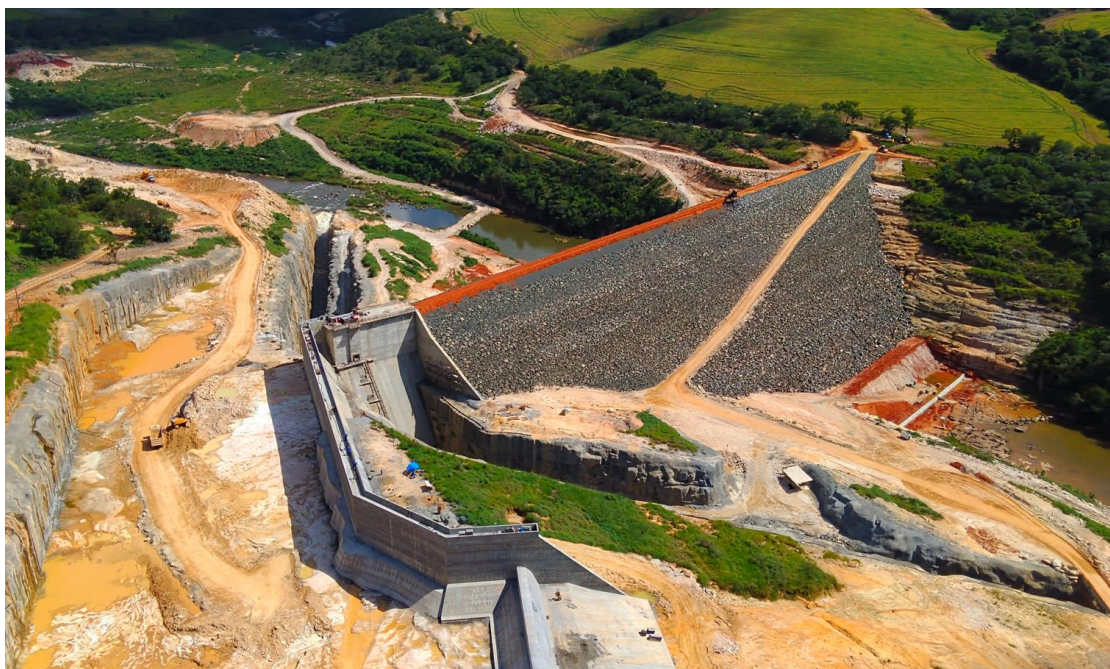
Figura. 03: Vista atual da Barragem Drone, em 12/03/2026. G5 Engenharia
