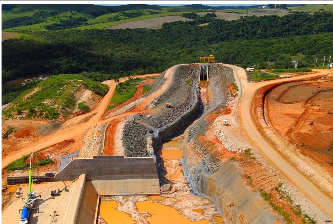
Figura 04: Vista aérea do Canal de Adução – Drone, em 13/03/2026. G5 Engenharia
