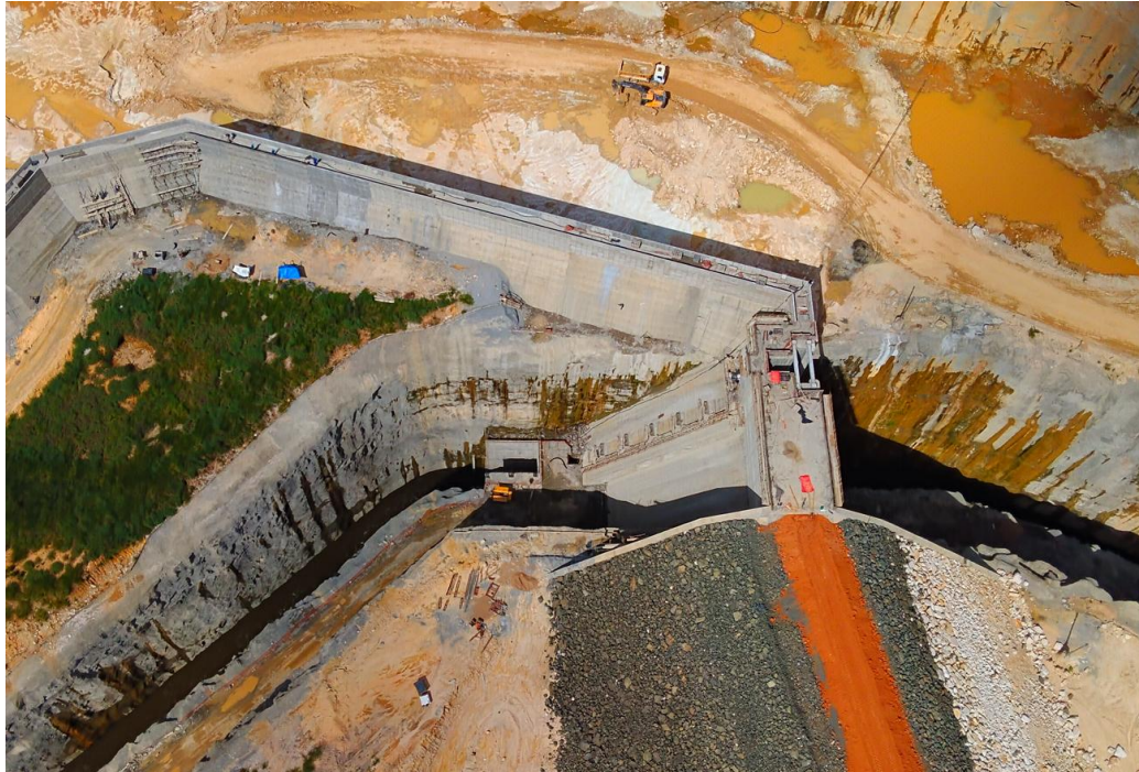
Figura 13: Providências finais na Casa de Força Auxiliar Em 13/03/2026. G5 Engenharia
