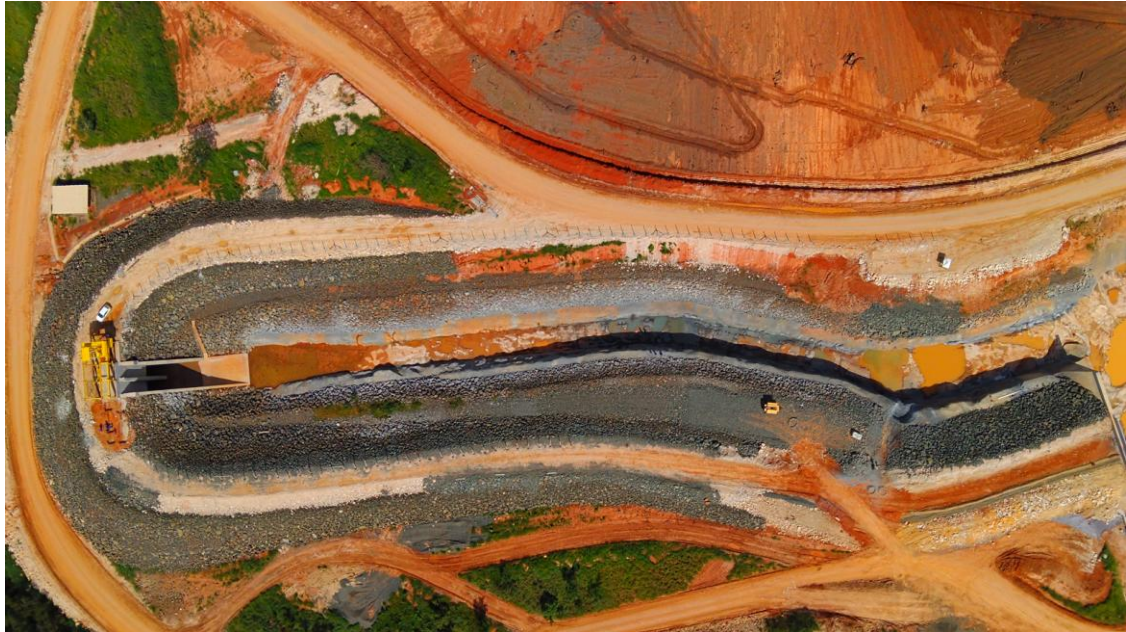
Figura 05: Canal de Adução Drone, em 13/03/2026. G5 Engenharia
