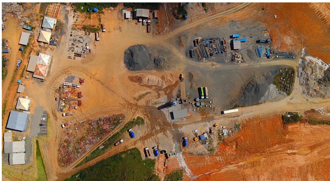
Figura 09: Vista geral da área do Canteiro de Obras Drone, em 17/03/2026, G5 Engenharia.
