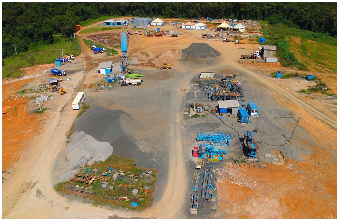
Figura 07: Trabalhos de resolução de não-conformidades apontadas Registros de 17/03/2026, G5 Engenharia
