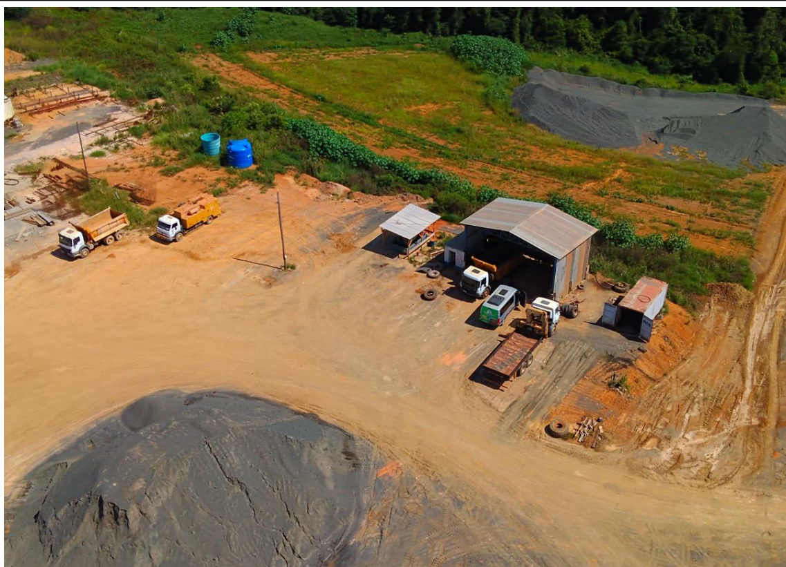
Figura 08: Pátio de máquinas e equipamentos – Registro em 17/03/2026 – G5 Engenharia.
