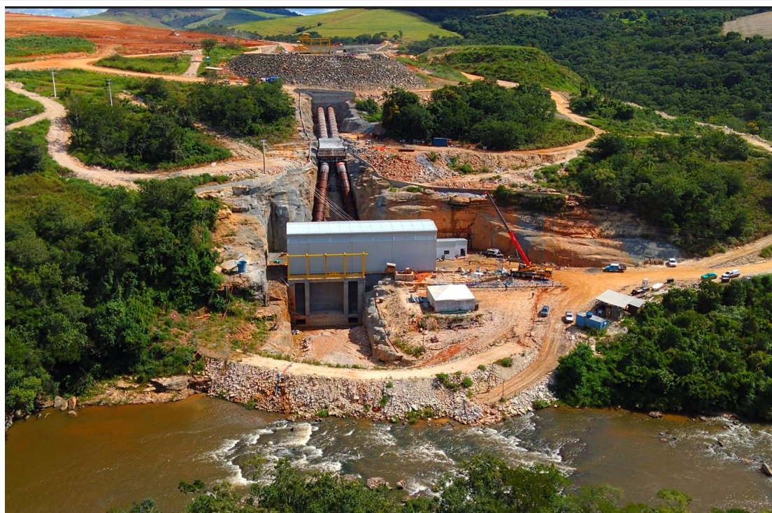
Figura 14: O canal de fuga será completado no período de enchimento do Reservatório Drone em 13/03/2026. G5 Engenharia
