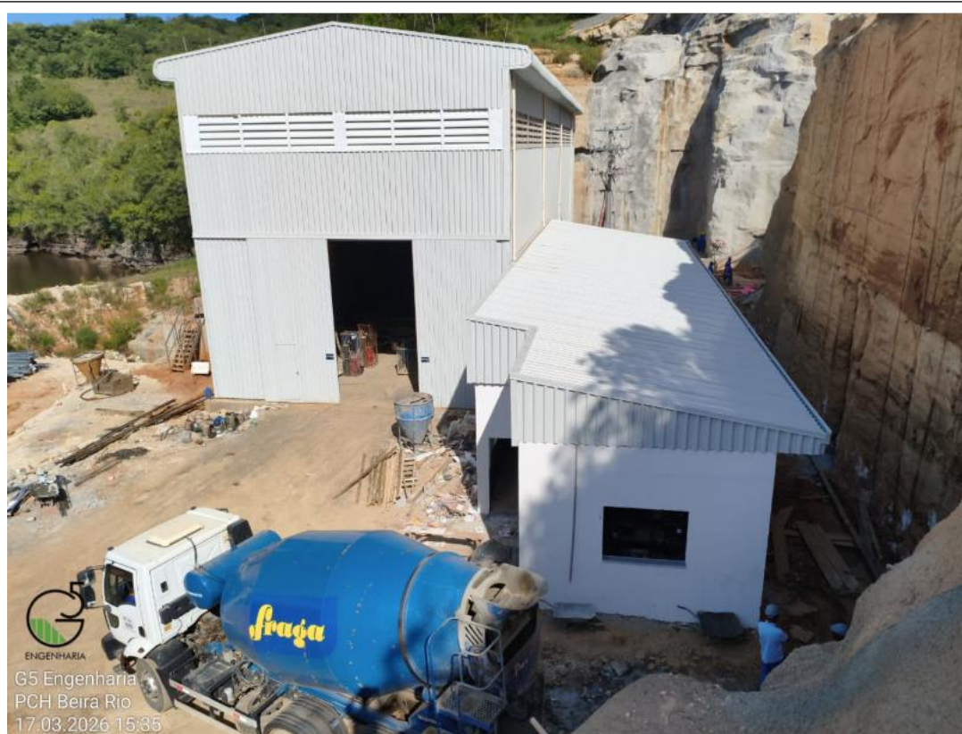
Figura 11: Alvenaria da sala de controle na casa de força Registro em 17/03/2026 – G5 Engenharia
