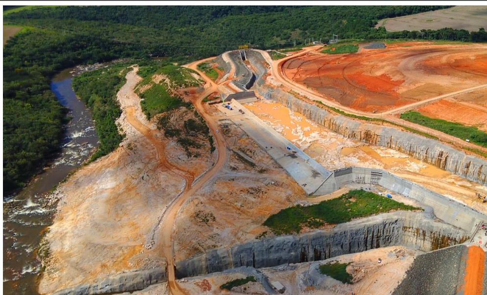
Figura 10: Bota-espera removidos do setor onde se instalará o vertedouro. Drone, em 13/03/2026. G5 Engenharia
