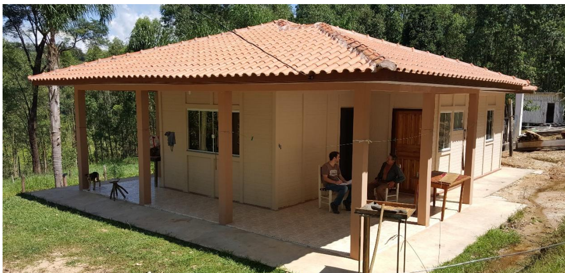
Figura 46: Residência 7, ocupada por José Ortiz da Pesqueiro Energia S/A.
