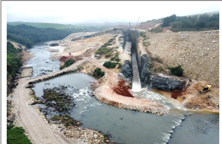
Figura 08: Vista aérea do início do fluxo pelo canal de desvio. Autor Iuri Bayerl 25_jun_2025
