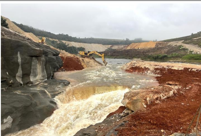
Figura 13: Abertura do canal de desvio. Autor Iuri Bayerl 25_jun_2025
