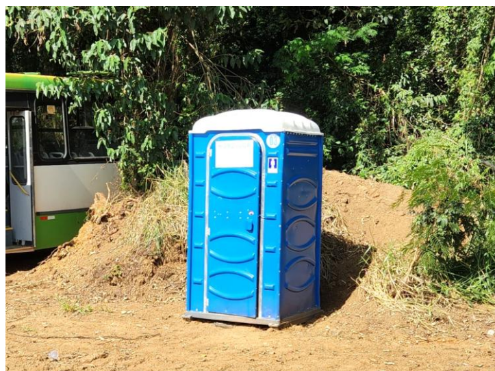
Fig. 04. Banheiro para peões espalhados pela obra. A. Muller 2025
