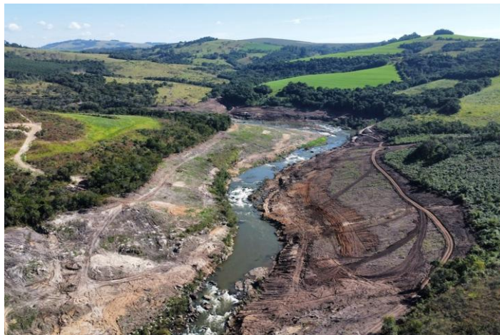
Figura 02: Área do futuro reservatório após supressão florestal . Autor Iuri Bayerl 19_jun_2025
