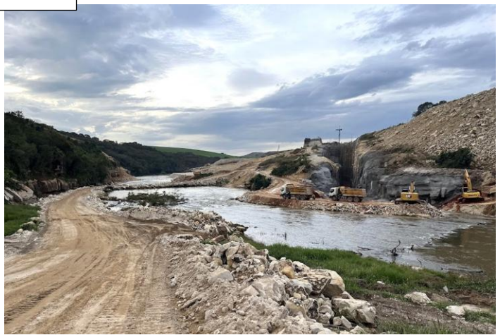
Figura 09: Operação de abertura do canal de desvio. Autor Iuri Bayerl 25_jun_2025
