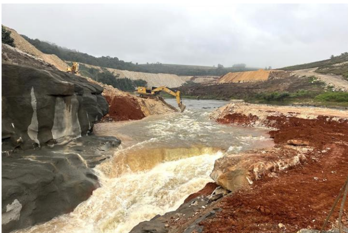
Figura 13: Abertura do canal de desvio.
