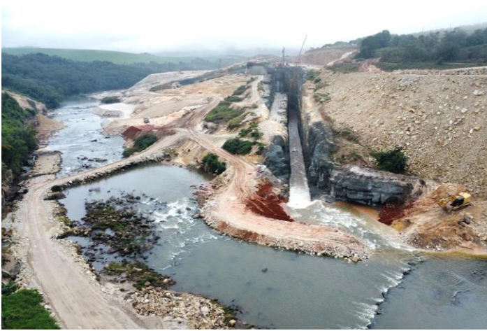
Figura 08: Vista aérea do início do fluxo pelo canal de desvio. Autor Iuri Bayerl 25_jun_2025
