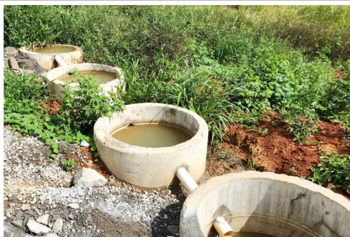
Figura 12: Dispositivo para reter as águas da lavagem dos caminhões.
