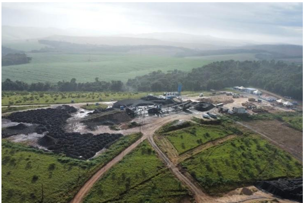
Figura 01: Canteiro de obras PCH Beira Rio
