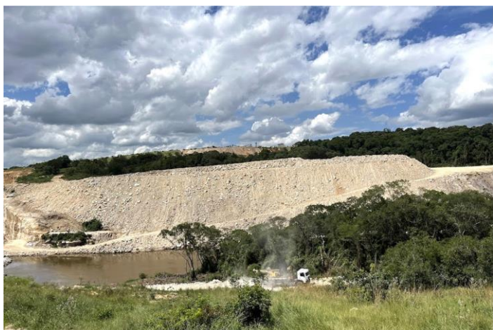
Figura 11: Bota espera na área do futuro reservatório.
