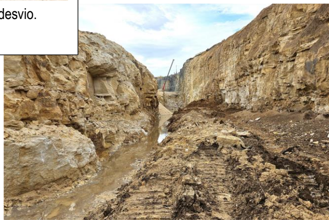
Figura 06: Interior do canal de desvio. Autor A.Muller 06_Nov_2024
