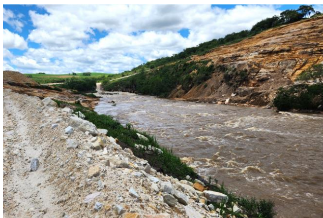
Figura 04: Área do futuro barramento.
