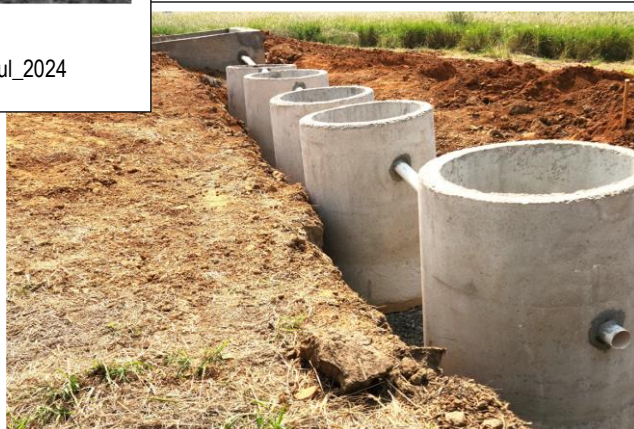
Figura 15: Sistema de filtragem de água de lavagem de caminhões.
