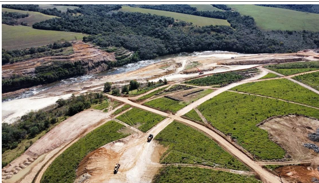
Figura 02: Canteiro de obras da PCH Beira Rio
