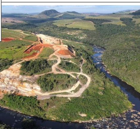
Figura 04: Canteiro de obras da PCH Beira Rio Autor Iuri Bayerl 08_Mai_2024
