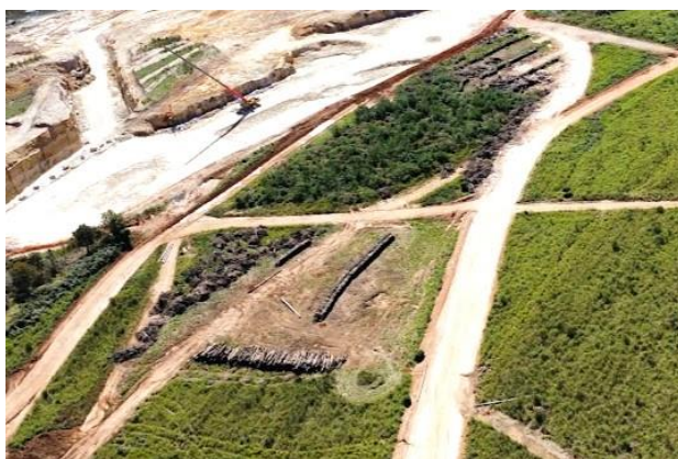
Figura 20: Depósito temporário de material lenhoso Autora Iuri Bayerl 17_Jun_2024
