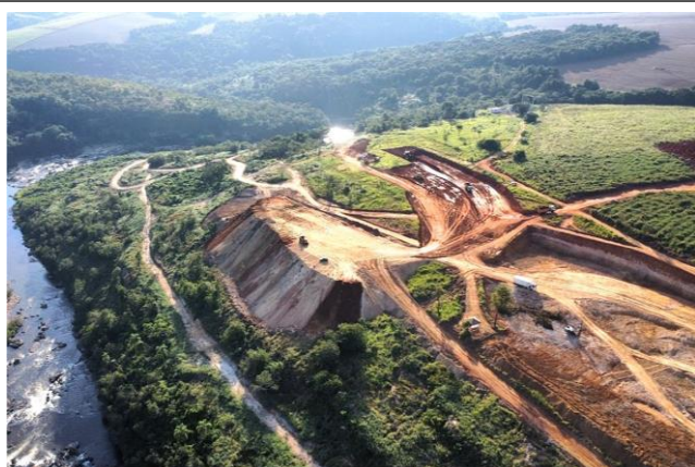
Figura 03: Canteiro de obras da PCH Beira Rio Autor Iuri Bayerl 08_Mai_2024
