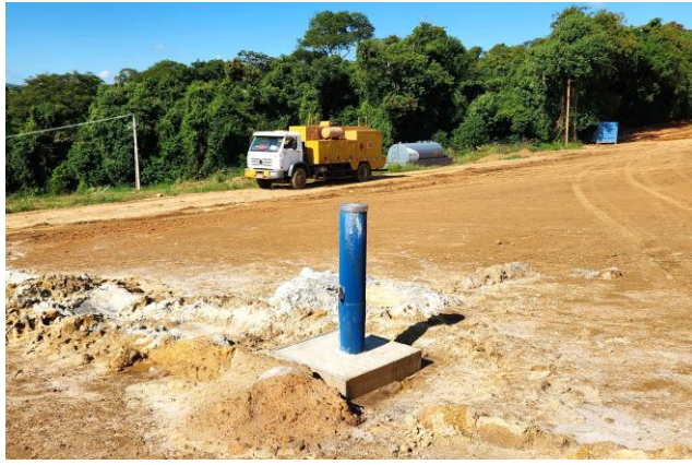
Figura 18: Poço artesiano implantado no canteiro de obras Autora A.Muller 11_Abril_2024
