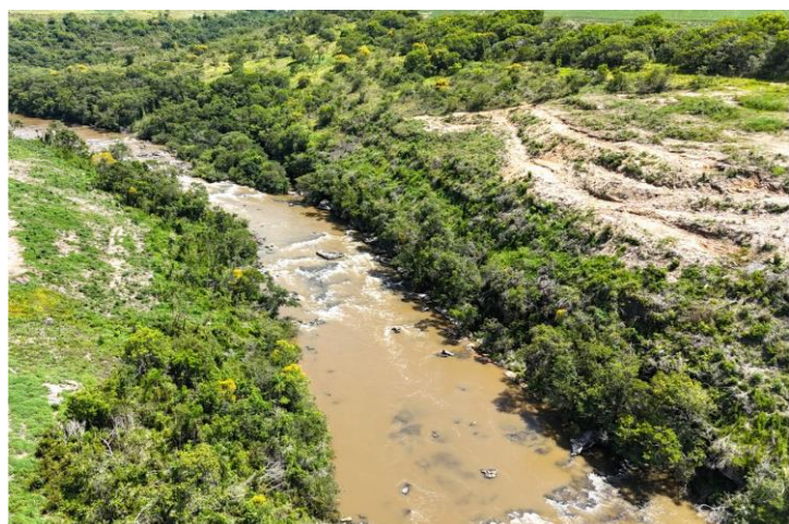
Figura 01: Área do futuro barramento da PCH Beira Rio Autor A.Muller 01_Fev_2024
