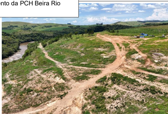
Figura 02: Canteiro de obras no início das obras. Autor A.Muller 01_Fev_2024
