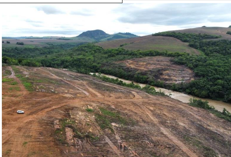
05. Área do Canteiro de Obras PCH Beira Rio luri Bayerl 20_Out_2023
