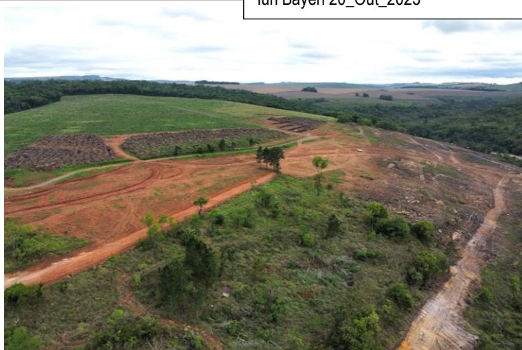
06. Área do Canteiro de Obras PCH Beira Rio luri Bayerl 20_Out_2023
