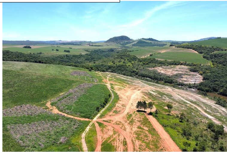
08. Canteiro de obras aguardando inicio das obras. luri Bayerl 14_Dez_2023
