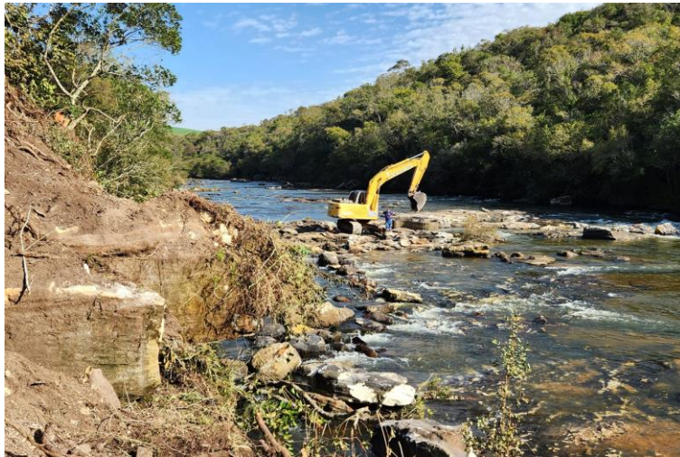
07. Iniciando a travessia do Jaguariaíva no Canteiro de Obras A.Muller 17_jul_2023
