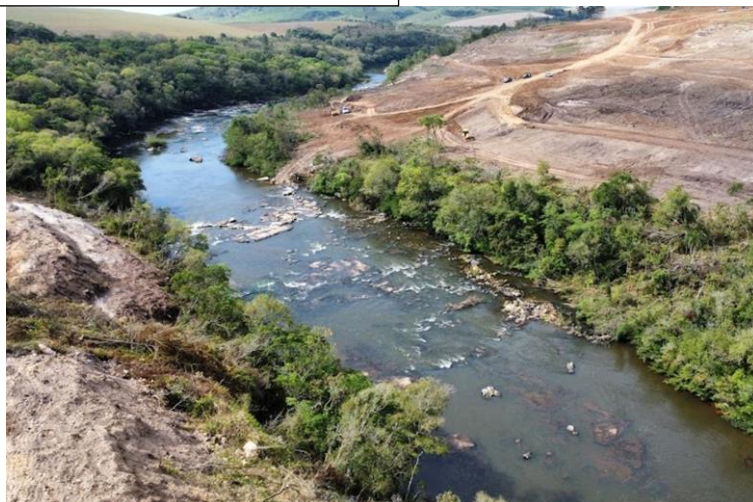
05. Área do Canteiro de Obras da PCH Beira Rio luri Bayerl 19_set_2023
