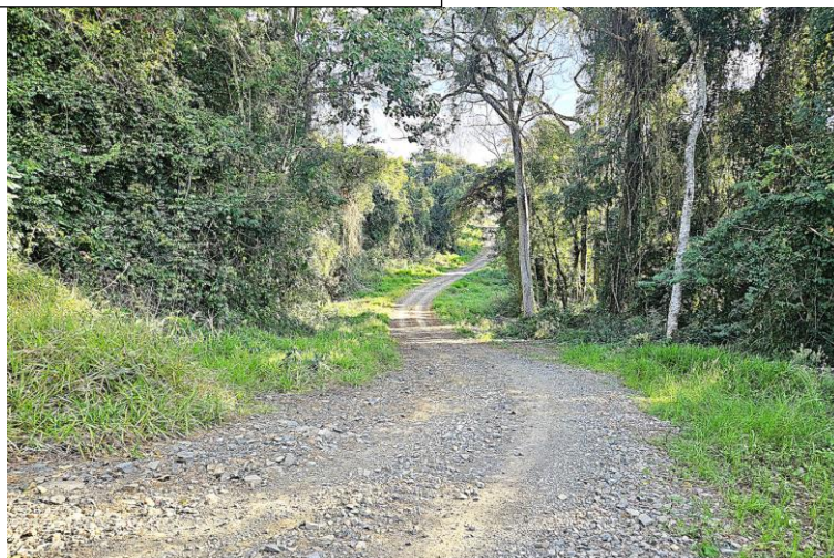
11. Acesso do canteiro de obras antes da mobilização do canteiro. A.Muller 17_ago_2023
