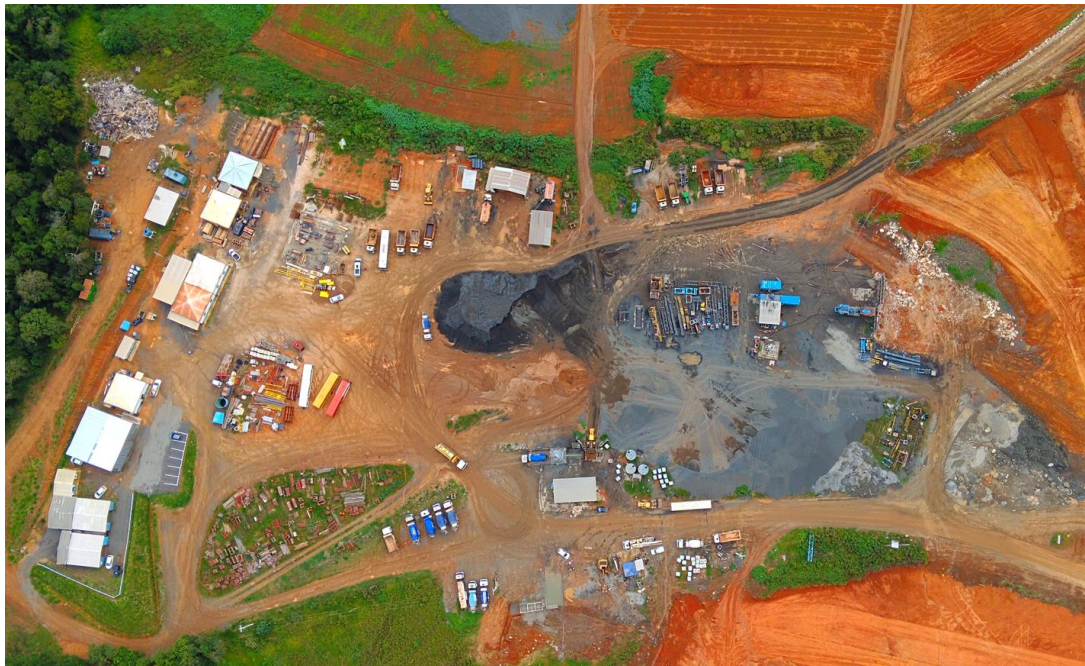
Figura 11: Vista geral da área do Canteiro de Obras Drone, em 12/02/2026, Engenharia.
