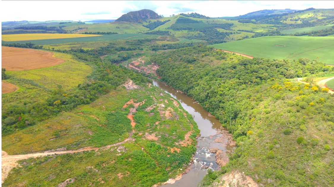
Fig. 01: Área com formação vegetal situada em encosta rochosa. Drone em 12/02/2026 fonte: G5 Engenharia
