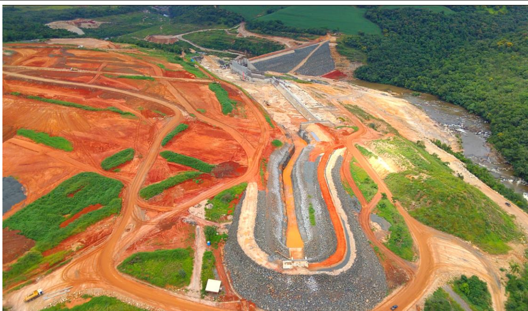
Figura 06: Vista aérea do Canal de Adução – Drone, em 12/02/2026. G5 Engenharia
