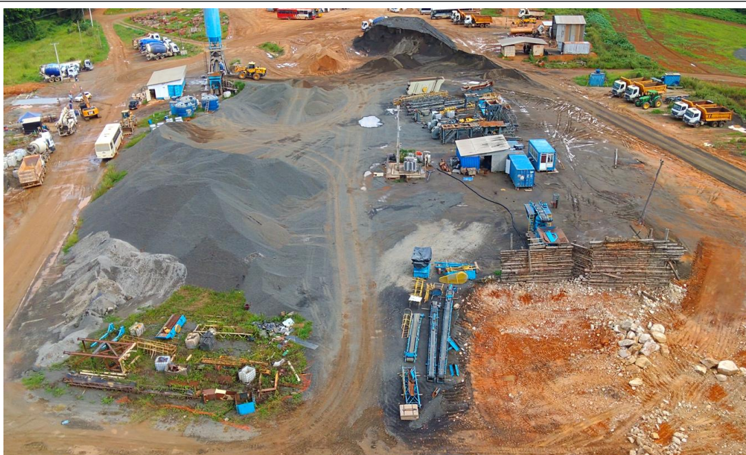
Figura 08: Áreas do canteiro de onde foram retirados materiais não mais necessários. Fonte: registros de 12/02/2026
