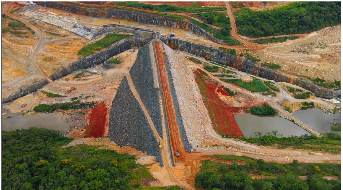
Figura. 05: Vista atual da Barragem Drone, em 12/02/2026. G5 Engenharia
