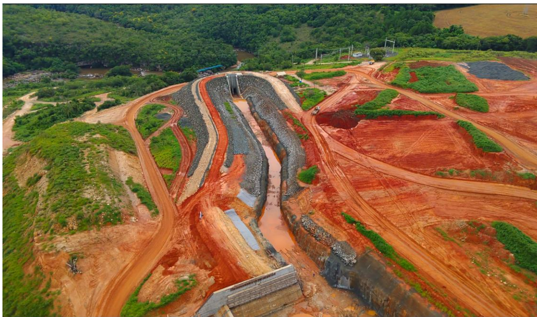
Figura 07: Canal de Adução Drone, em 12/02/2026. G5 Engenharia
