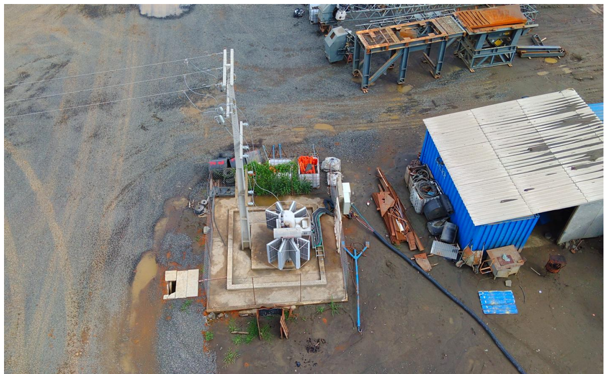
Figura 09: Trabalhos de resolução de não-conformidades apontadas Registros de 12/02/2026, G5 Engenharia
