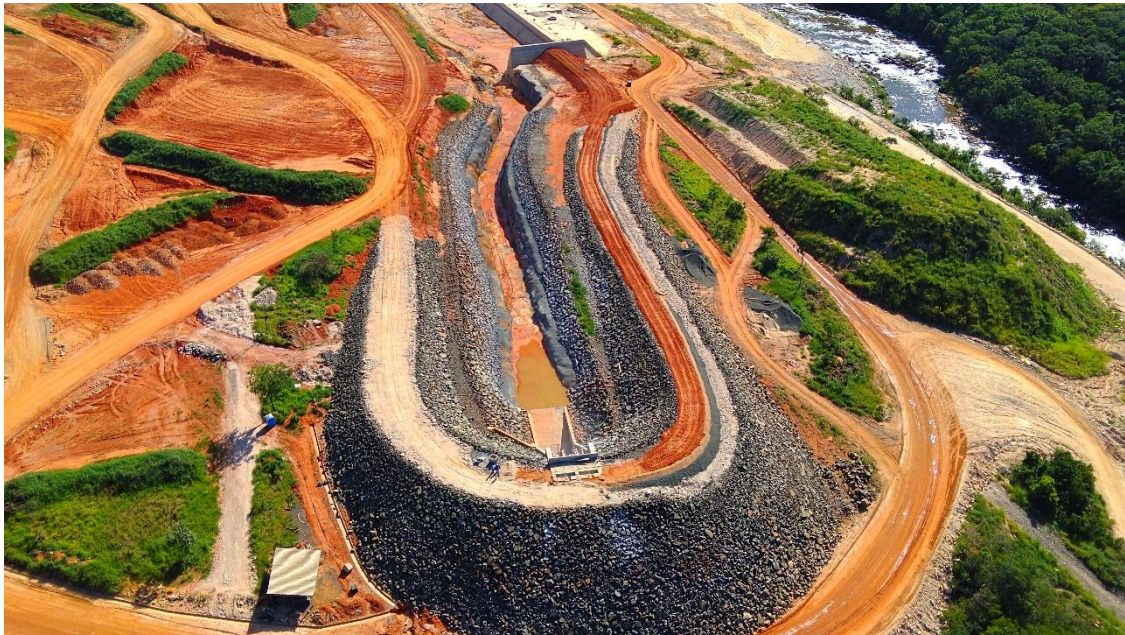
Figura 07: Canal de Adução – Drone, em 12/01/2026. Engenharia
