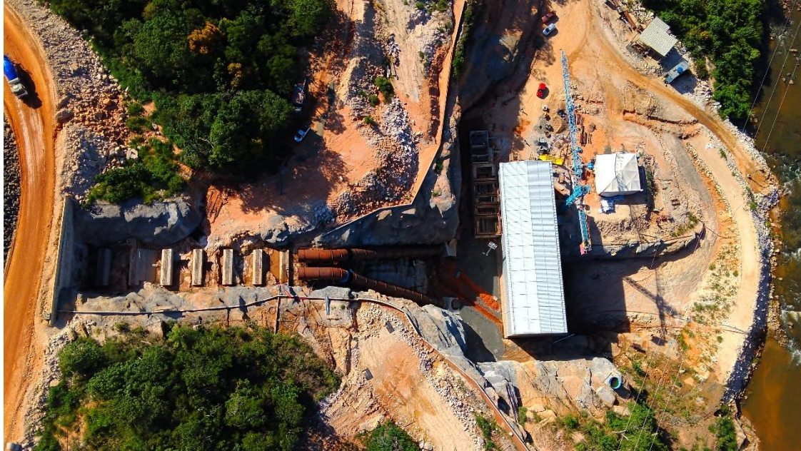
Figura 13: Casa de Força – Drone, em 13/01/2026. Engenharia
