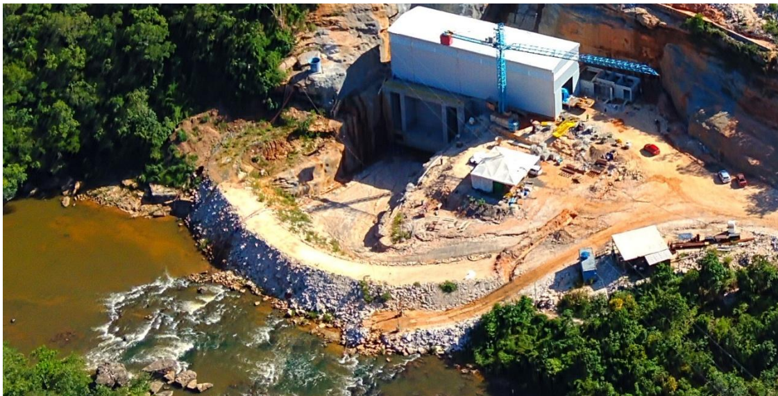
Figura 16: Ensecadeira do canal de fuga será removida na fase da AA de Testes
