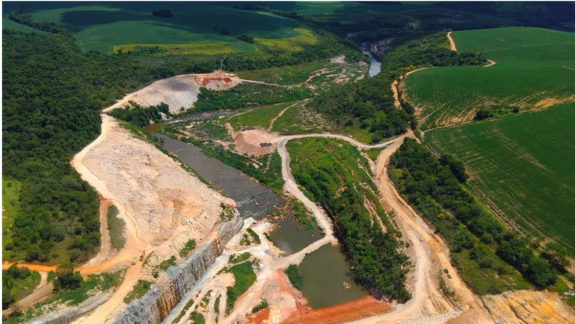
Fig. 01: Área do reservatório próxima à barragem. Drone em 15/01/2026 Engenharia
