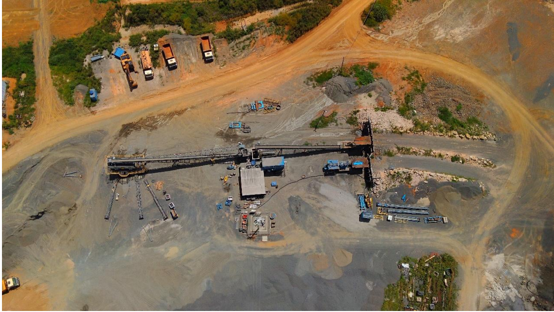
Figura 09: Britador – Drone, em 15/01/2026, Engenharia
