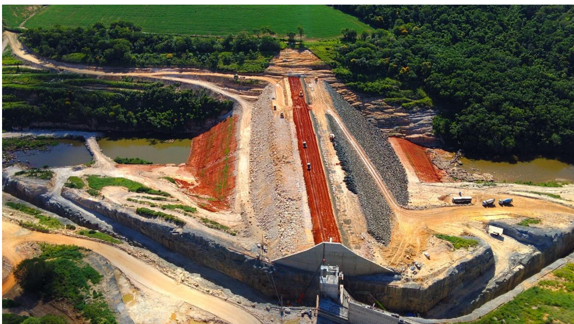
Figura. 04: Barragem – Drone, em 13/01/2026. Engenharia
