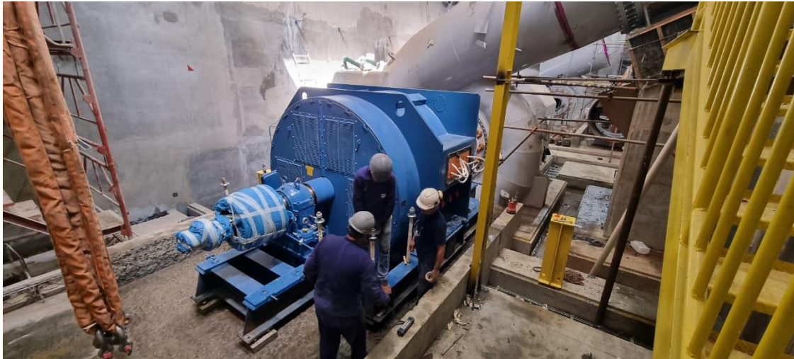
Figura 15: Montagem do sistema gerador na Casa de Força – em 15/12/2026. Engenharia
