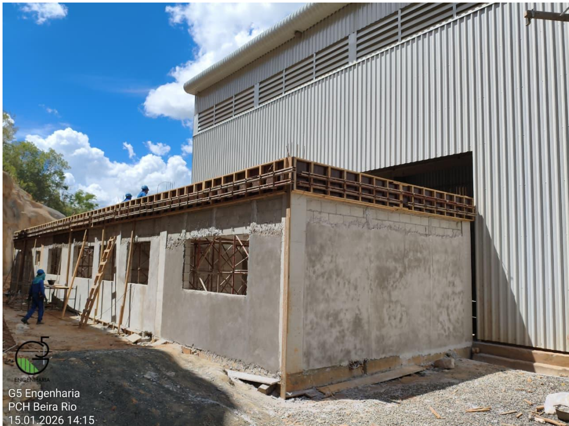
Figura 14: Edifício de controle da Casa de Força, em 15/12/2026. Engenharia
