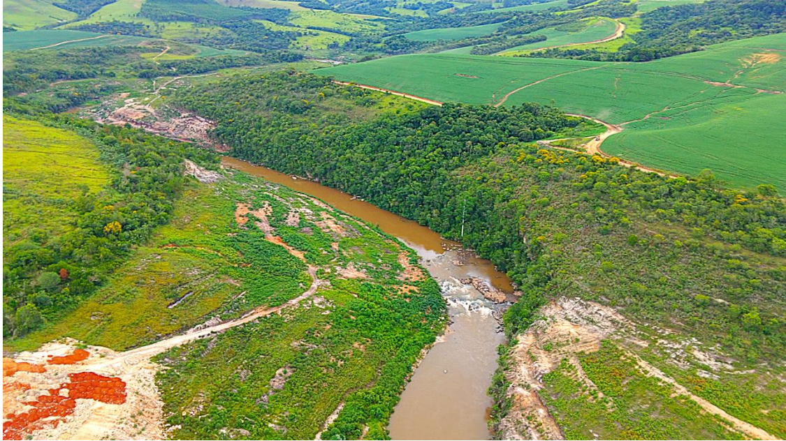
Fig. 03: Setor do Reservatório, com vegetação remanescente - Drone, 15/01/2026 Engenharia
