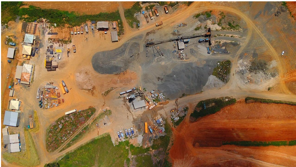
Figura 08: Área do canteiro de obras – Drone, em 15/01/2026. Engenharia
