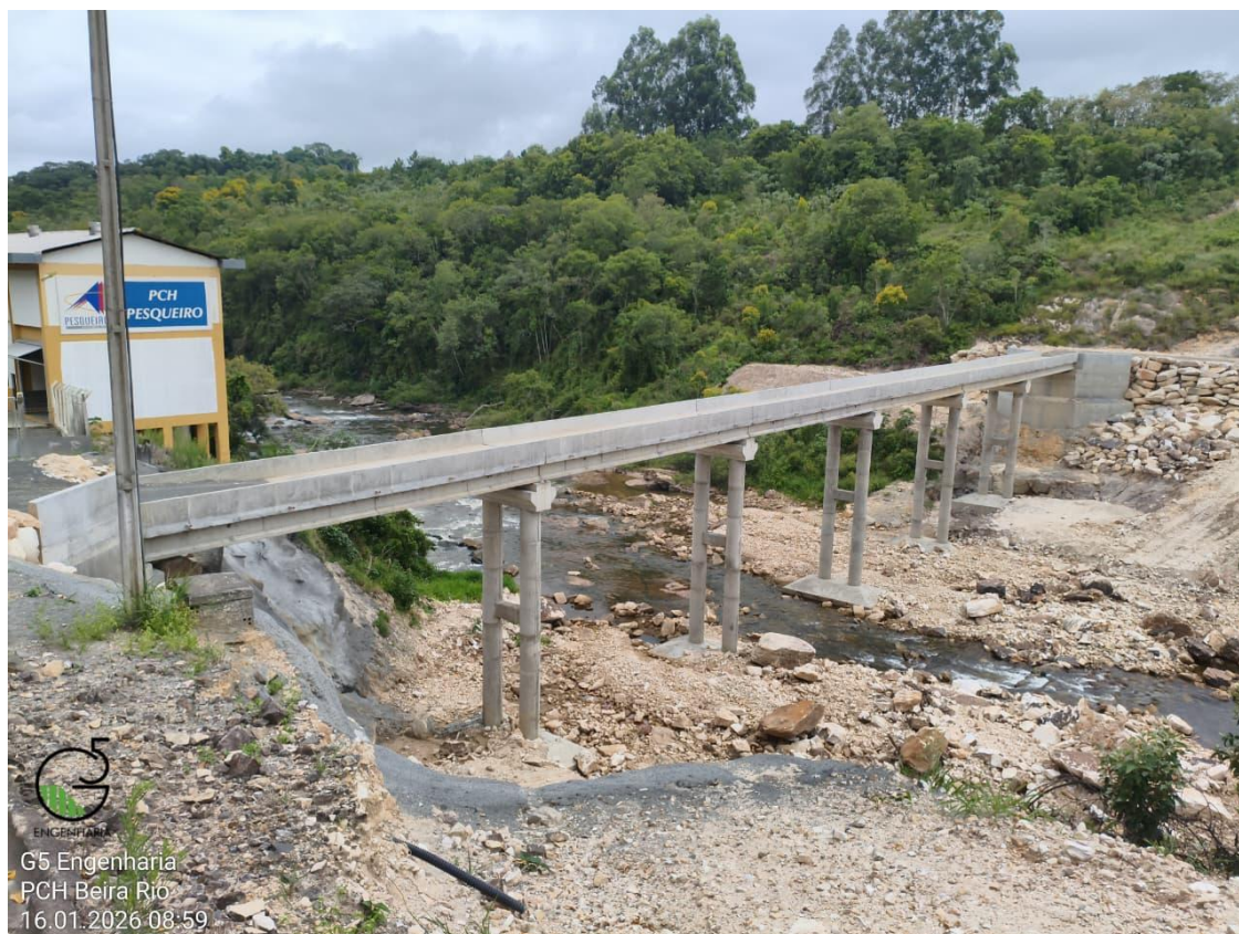
Figura 17: Ponte de serviço está em fase de conclusão. Foto, em 16/01/2025.
