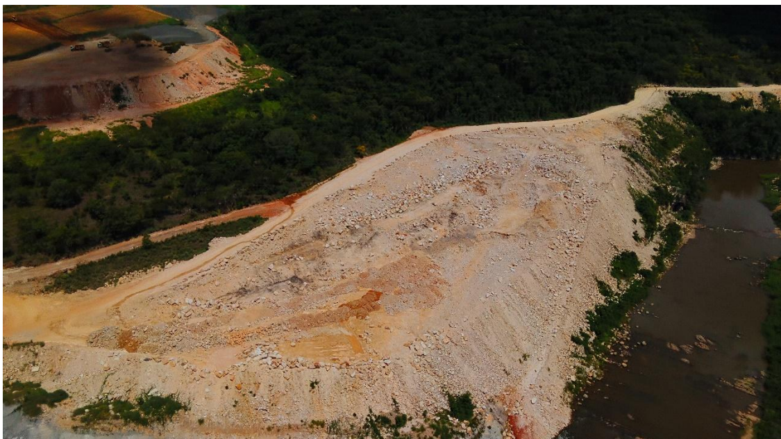
Figura 12: Área dos bota-espera sendo removidos. Drone, em 15/01/2026 Engenharia
