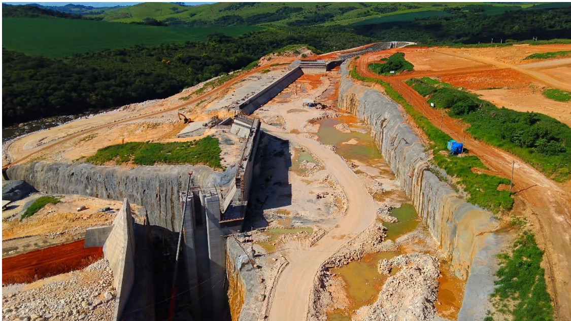
Figura 06: Vista aérea do Canal de Adução – Drone, em 12/01/2026. Engenharia
