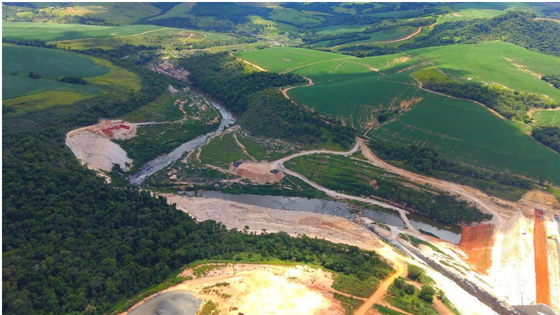
Figura 02: Setor do meio do Reservatório. Drone, em 15/01/2026 Engenharia
