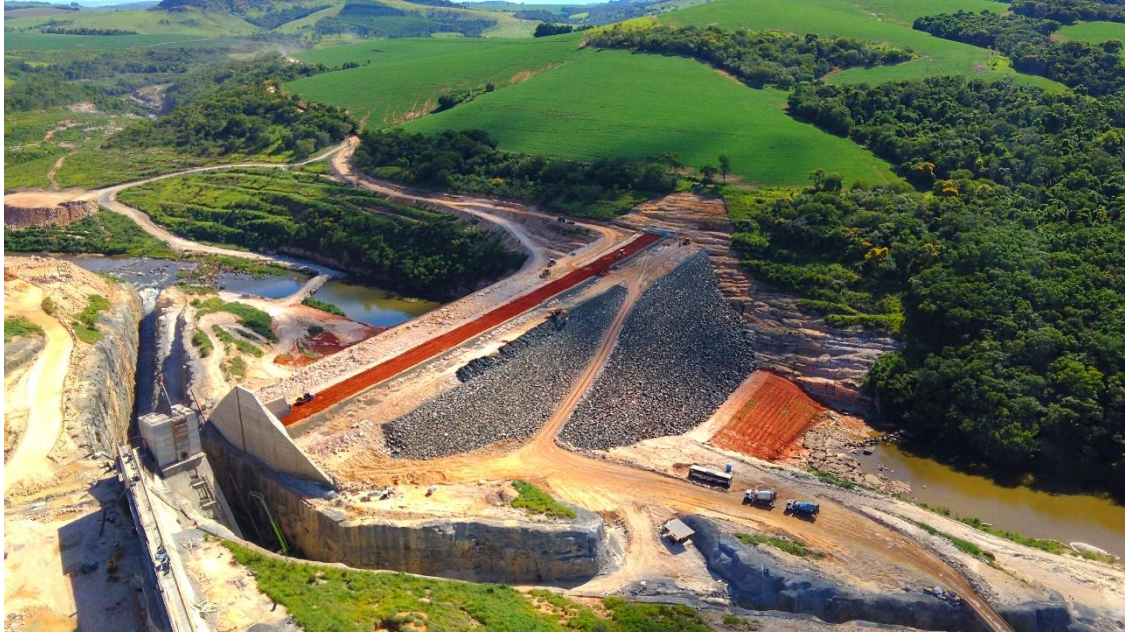
Figura 05: Barragem – Drone, em 12/01/2026 Engenharia
