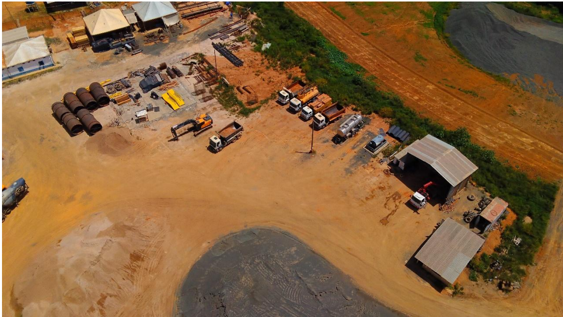
Figura 10: Pátio de máquinas e equipamentos – Drone, em 15/01/2026, Engenharia
